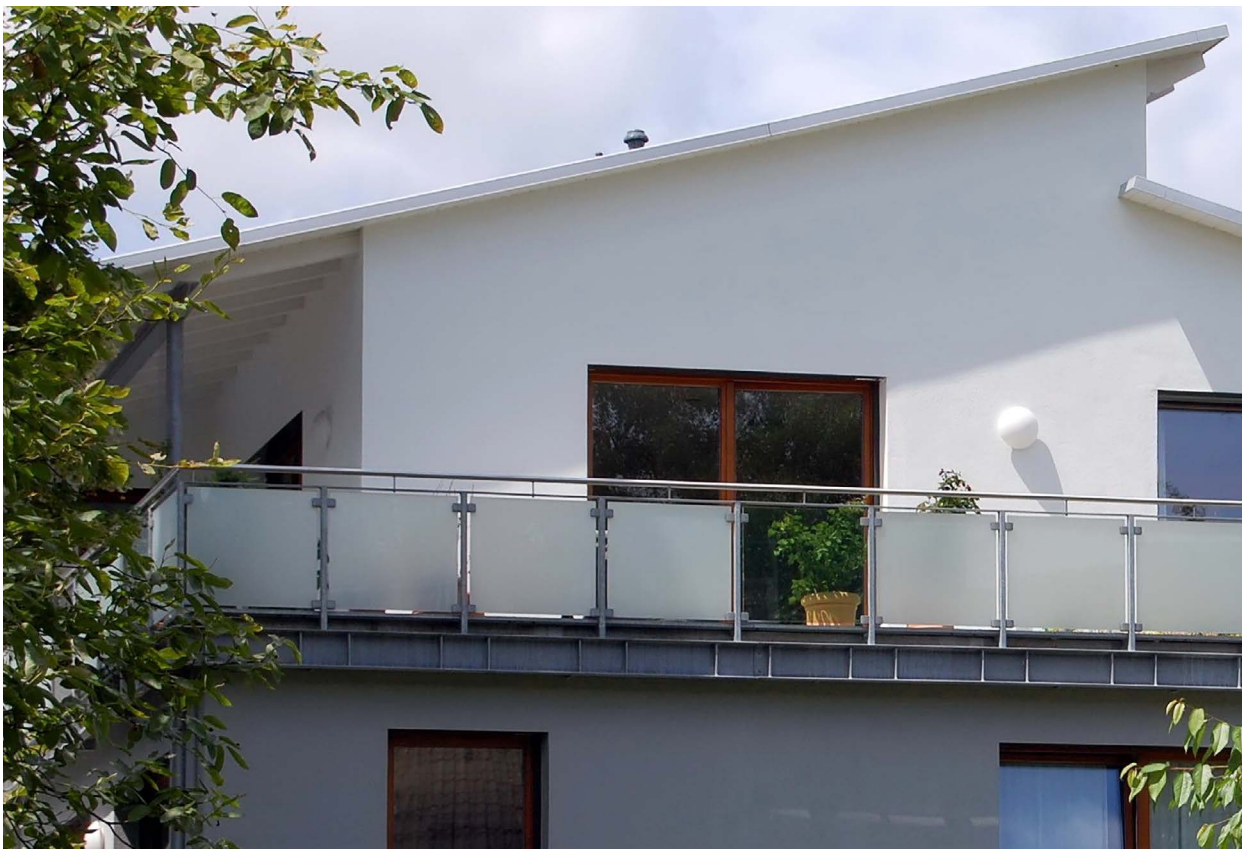
Ein großer Dachüberstand durch ein zurückgesetztes, aufgestocktes Dachgeschoss sorgt auf der Dachterrasse für einen baulichen Sonnenschutz. Transparente Brüstungselemente gewähren Ausblicke, wo sie gewünscht sind.
