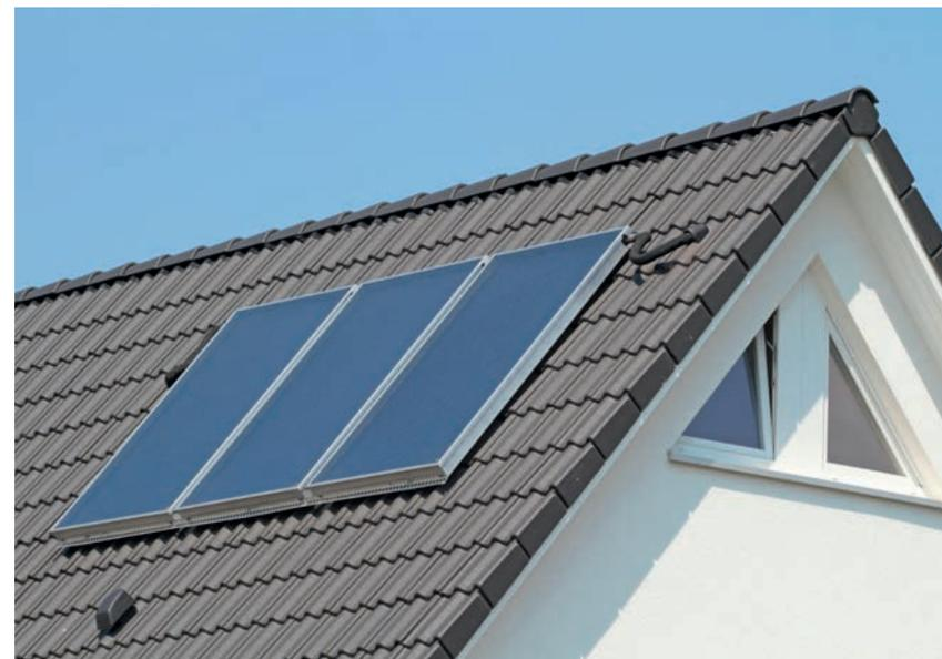
Mit solarthermischen Anlagen kann die Sonnenwärme nicht nur zur Warmwasserbereitung, sondern auch zur Heizungsunterstützung genutzt werden. Die Solarwärme wird über Kollektoren auf dem Dach gesammelt. Je nach Kollektortyp, Haushaltsgröße und Verwendung der Wärme müssen dafür zwischen 3 und  $12 \text{ m}^2$  Dachfläche eingeplant werden. Die Wärme
