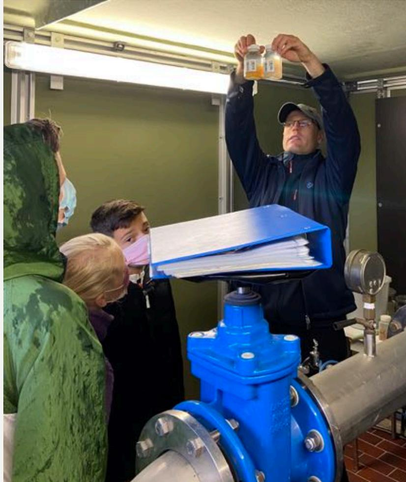
Das Wasser enthält bis zu diesem Schritt noch Schwefelwasserstoff.
